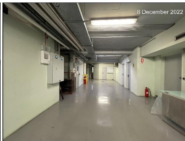
Άποψη υπογείων βοηθητικών χώρων
