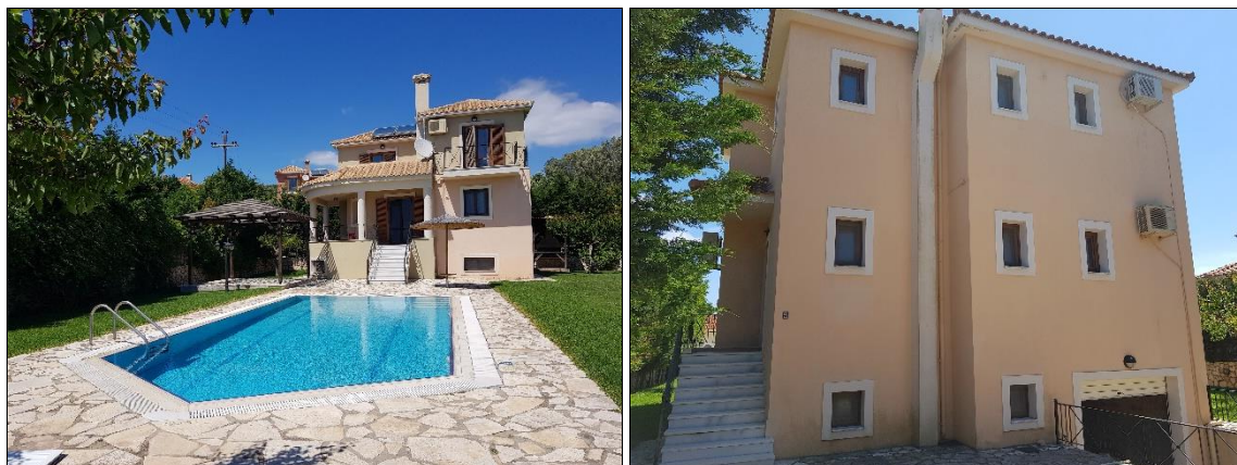
Εξωτερική άποψη των μεζονετών
