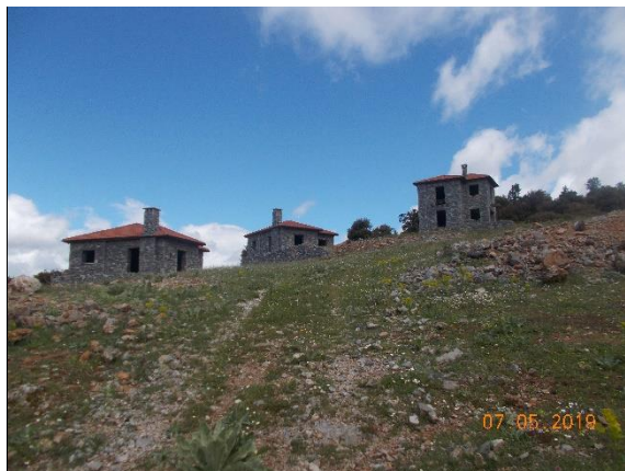
Εξωτερική άποψη των μεζονετών
