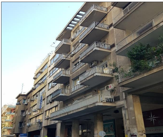
Γενική άποψη κτιρίου
