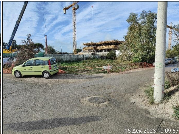
Άποψη από τη συμβολή Χειμάρας & δημοτικής οδού
