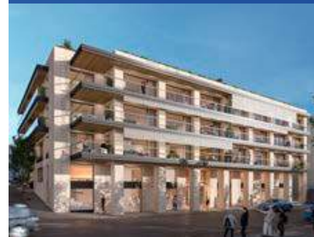
Κτήριο Κατοικιών και Γραφείων, Μετς (έργο σε εξέλιξη)
